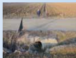
Neposredno odtekanje v vodotok po cevi
